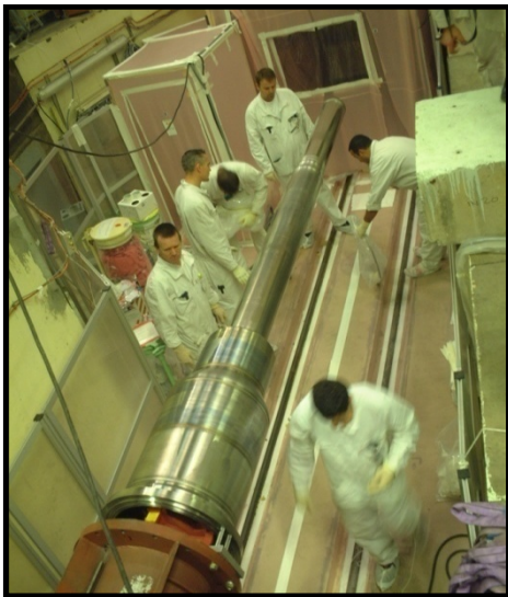
Nouveau doigt de gant H10 avant mise en place
